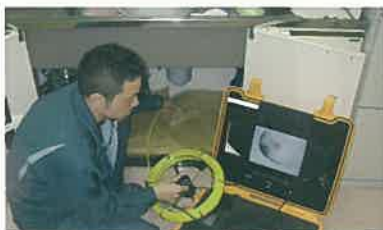
台所、配水管の調査
