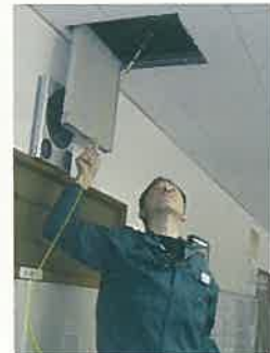
天井裏の調査
