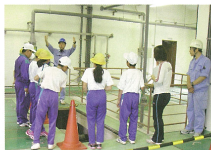
農業集落排水処理施設の見学
