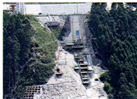
建設中のハツ場ダム
