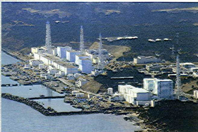
福島第一原子力発電所
