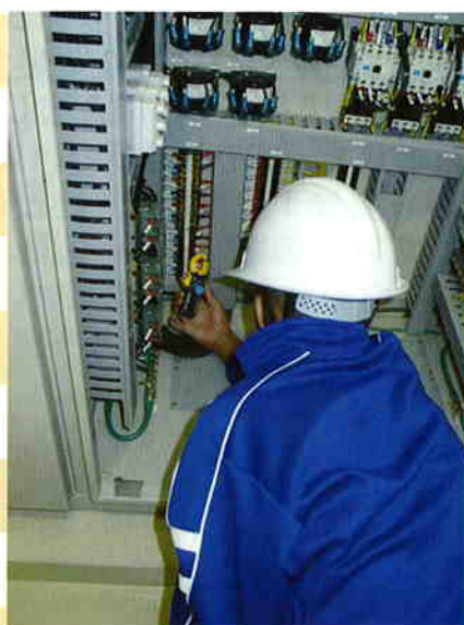
下水道処理施設で電気施設の点検
